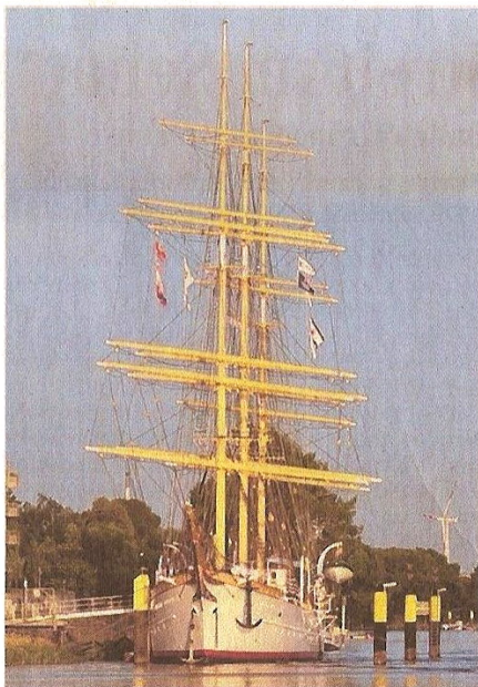
Muss dringend saniert werden: Das „Schulschiff Deutschland“. FOTO: KÖLLING
